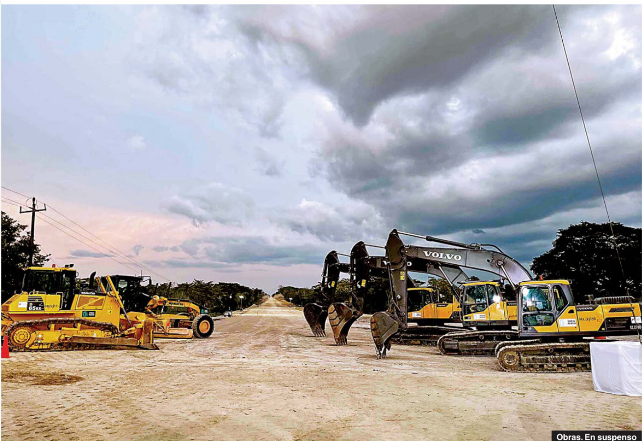
Obras. En suspenso
